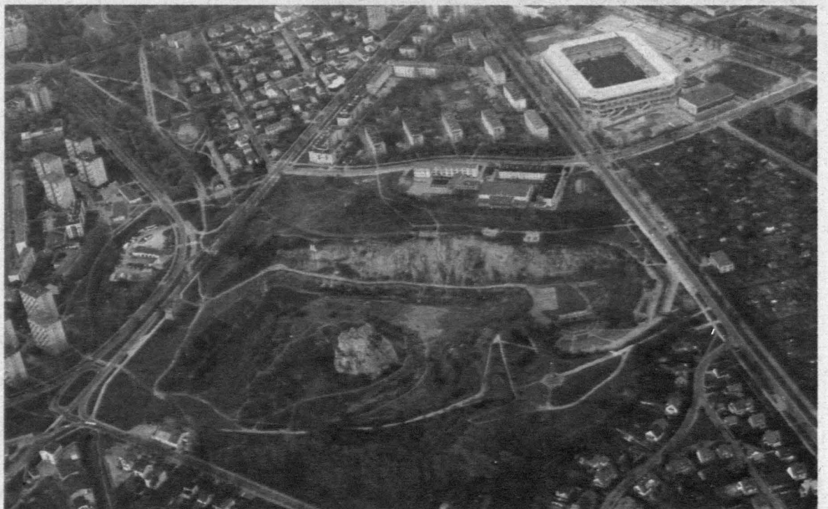
Stara Kadzielnia i nowy stadion
